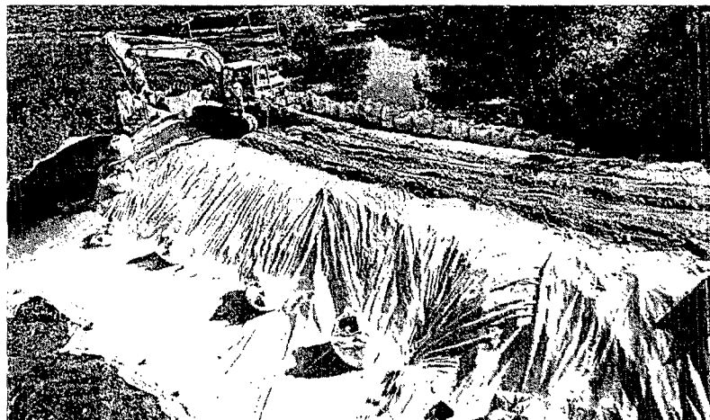
La construcción de diques y balsas fue la solución para frenar el avance de la contaminación. / LAMARCA PA. JH
