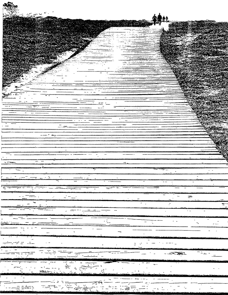
Unha pasarela de madeira constitúe o acceso a unha das marabllas galegas: as dunas de Corrubedo
