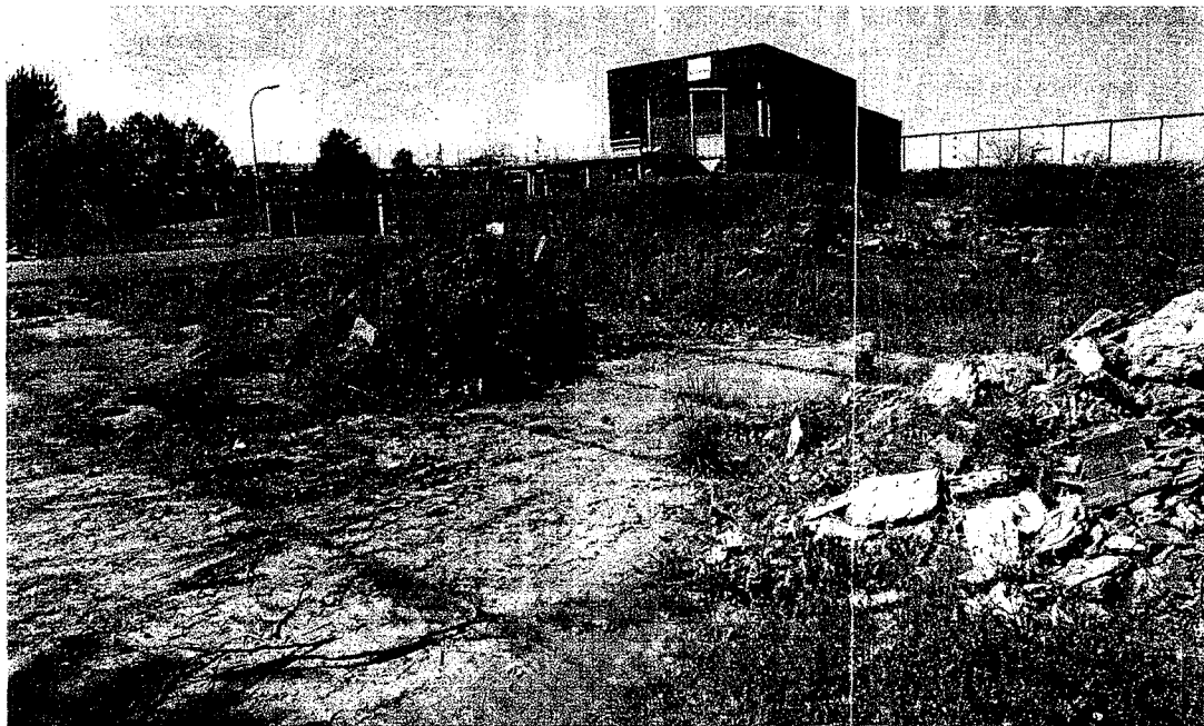
La planta de compostaje se construirá en la parcela municipal situada al lado de la ecoplanta de Sogama, en O Ceao
