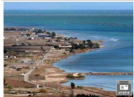
Imagen de la bahía de los Alfacs, donde se construirá el primer dique, de 16 kilómetros, que intentará contener la subida del agua.- JOSEP LLUÍS SELLART
