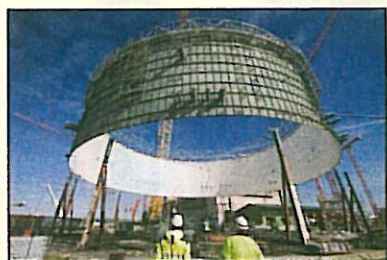
▲ Labores de construcción del tercer reactor en Olkiluoto 3
