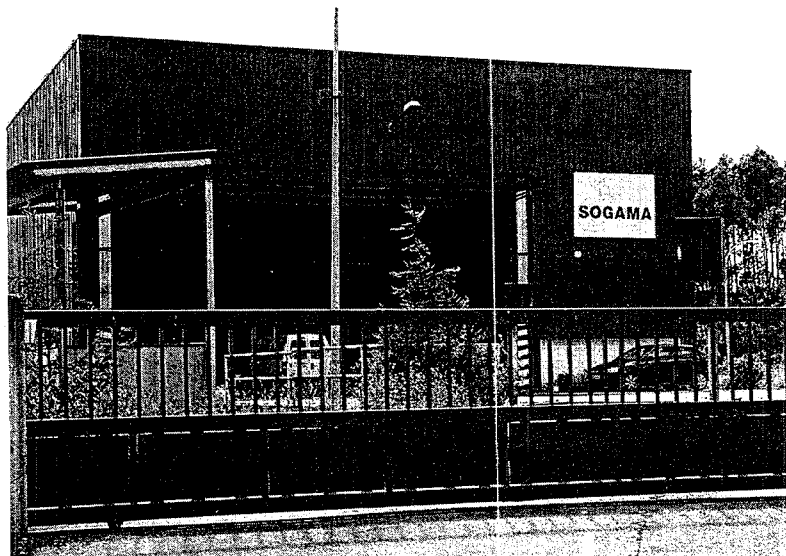
Instalaciones de Sogama en el polígono Industrial Río do Pozo, en el municipio de Narón
