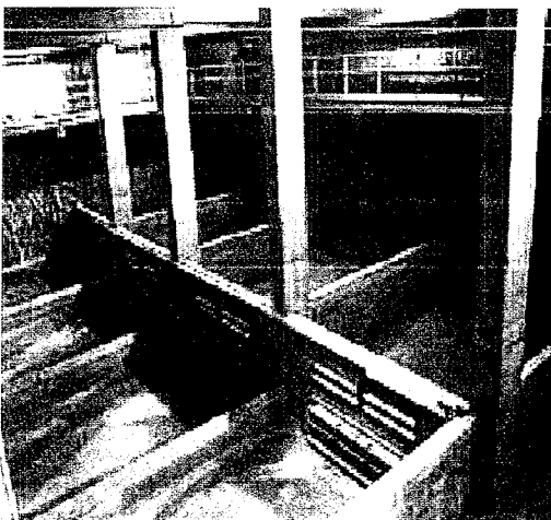
Tanque de tormenta
